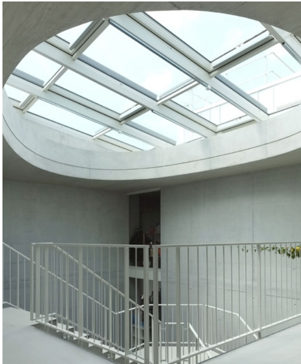
System VENTRIA 3 zamontowany jako skrzydło wentylacyjne w dachu jednospadowym
